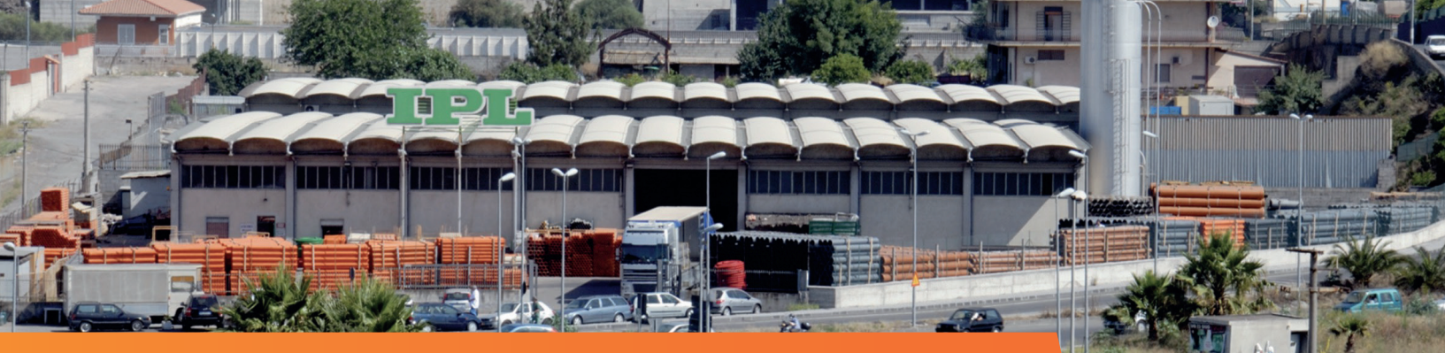
STABILIMENTO DI CATANIA 1985-2012
