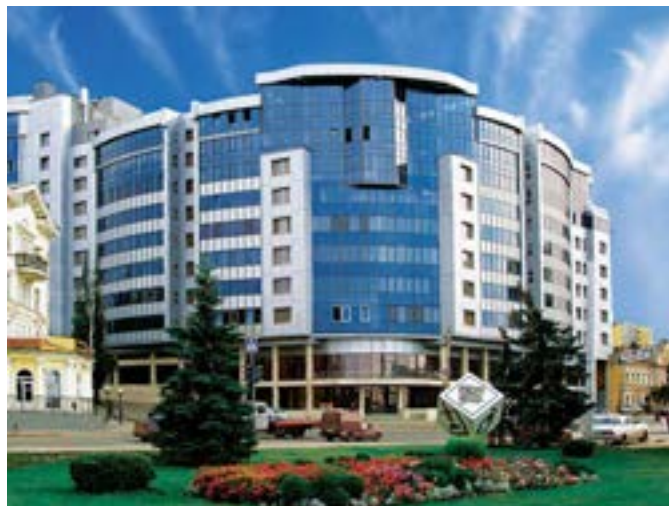
Complesso residenziale Zazerkalie - Samara (Russia)
