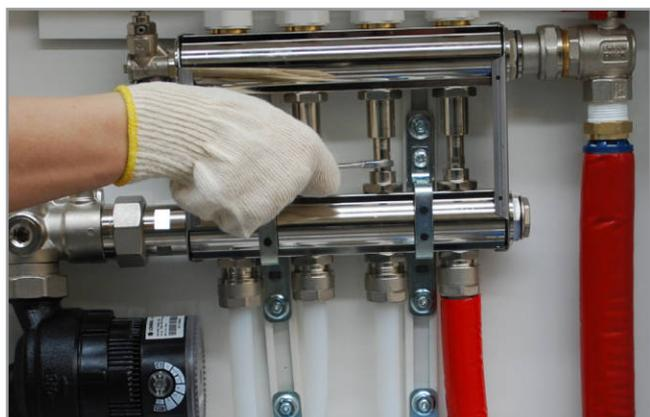
12. Regolazione della temperatura del liquido dei circuiti secondari con chiave inglese 11 mm.
