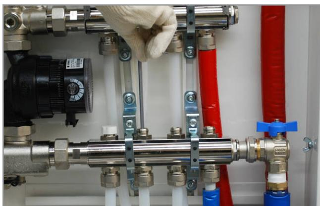
9. Riempimento impianto: chiusura dei successivi detentori ruotando la chiave a brugola in senso orario
