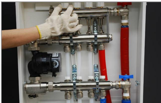
6. Riempimento impianto: chiudere le valvole di andata/ritorno del circuito primario (rossa e blu); apertura manuale del primo otturatore termostatico e ruotando in senso antiorario l'apposita manopola
