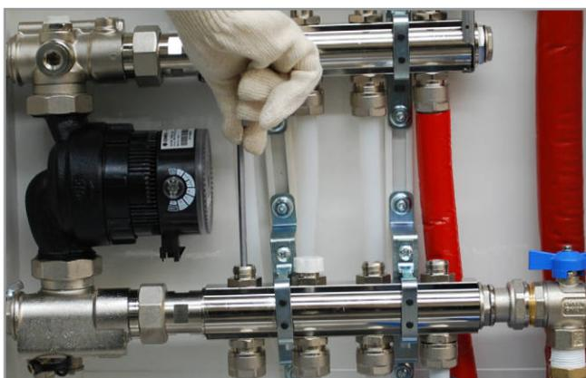
8. Riempimento impianto: apertura del primo detentore ruotando la chiave a brugola in senso antiorario
